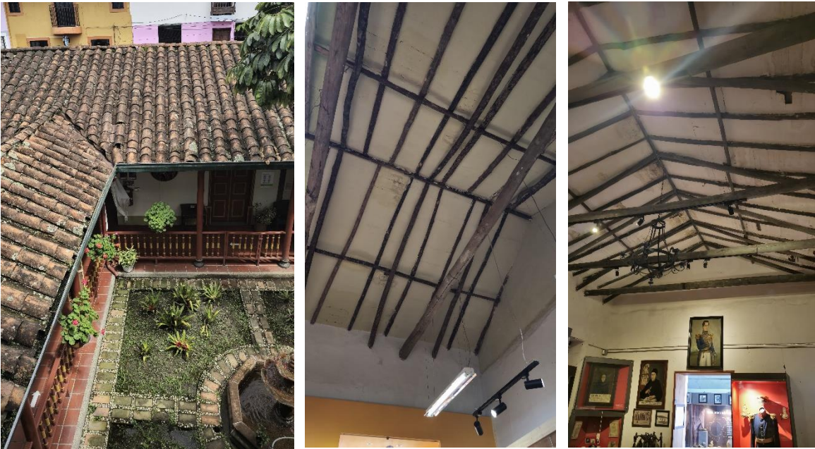
Imágenes 15, 16 y 17. Áreas con humedades en muros de tapia en la Casa de Cultura. Archivo personal.
