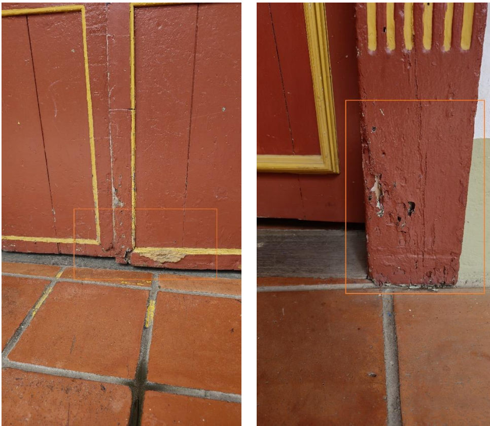
Imágenes 44 y 45. Daños en puertas fachada interna del bloque de estudio - Casa de Cultura. Archivo personal.
